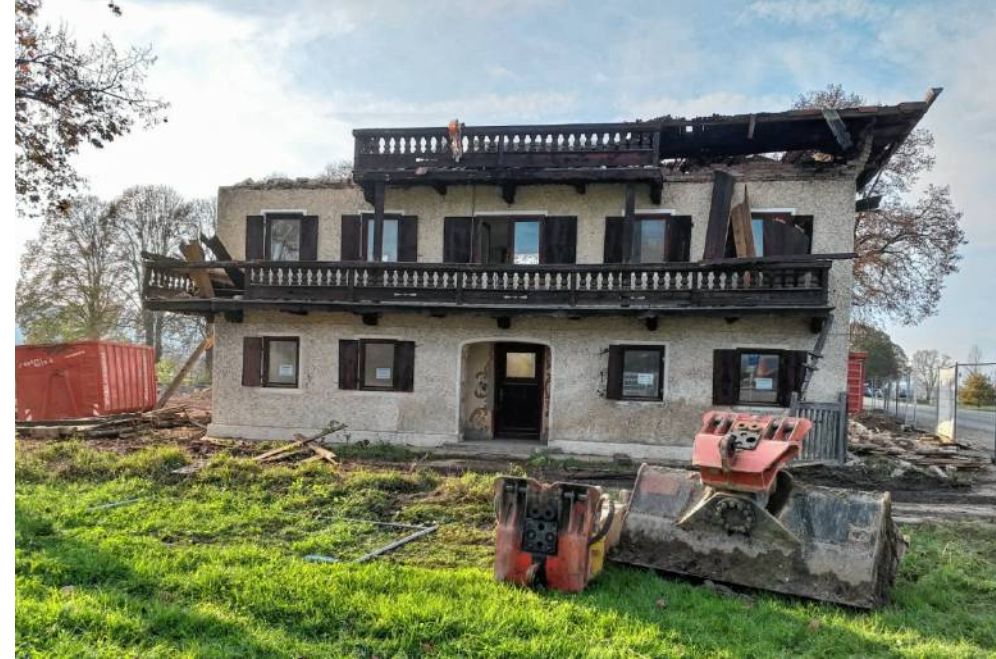
Das alte Bauernhaus in Ried wurde abgerissen.
