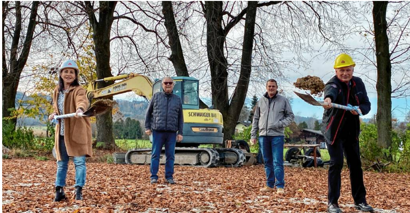
Setzen ein positives Zeichen im Corona-Jahr: Renate Holland, Vorsitzende des Vereins Gnadenhof Katzentraum, Josef und Franz-Josef Schwaiger von der Baufirma und Bürgermeister Richard Richter (von links) beim ersten Spatenstich für das neue Domizil des Katzentraums – natürlich mit entsprechendem Sicherheitsabstand.
